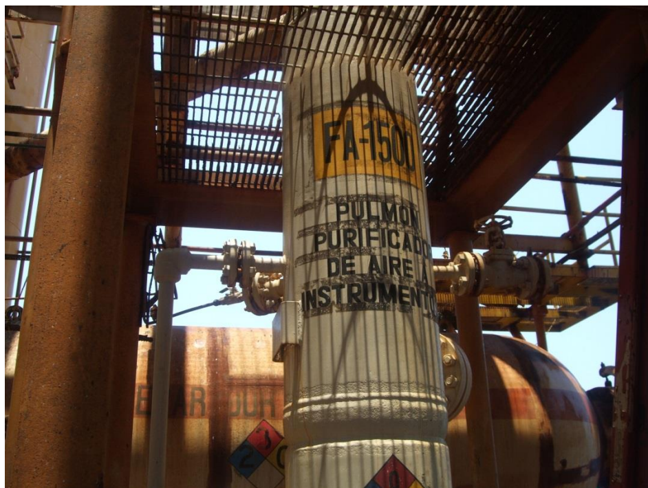
Fig. 3 Tanque almacenamiento aire instrumentos fuera de servicio
